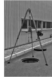
1. Rettungs-Dreibein über dem geöffneten Schacht
