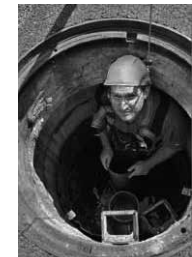
6. In den Schacht hineinsteigen und auf Filterelemente stellen
