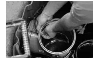
2. Mutter am T-Stück (Ablauf) lösen und abnehmen
