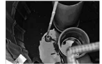
3. Wasserprobe oberhalb der Filterelemente entnehmen.
