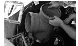
3. T-Stück komplett herausnehmen und aus dem Schacht herausheben
