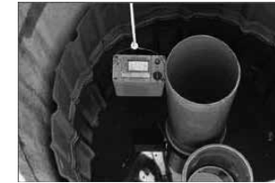
2. Mit Gaswarngerät Atmosphäre im Schacht prüfen und ständig überwachen
