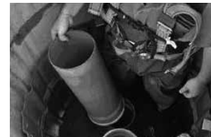
1. Wartungsrohr aus der Muffe ziehen und aus dem Schacht herausheben
