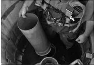
1. Wartungsrohr aus der Muffe ziehen und aus dem Schacht herausheben
