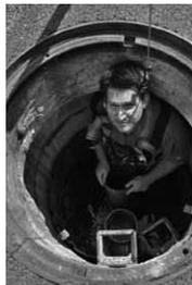
6. In den Schacht hineinsteigen und auf Filterelemente stellen
