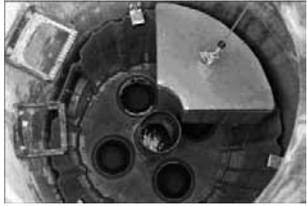
1. Filter mit Winde in den Schacht herablassen und in Dichtungen stecken
