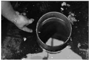
4. Aufstomsicherung an beiden Seiten nach außen ziehen
