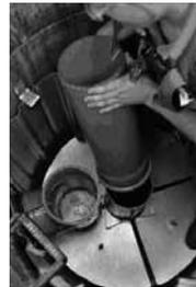
6. Wartungsrohr mit Verschlussdeckel auf das mittlere Rohr stecken und befestigen
