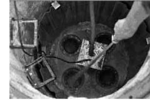
5. Dichtungen für die Filterelemente gründlich spülen
