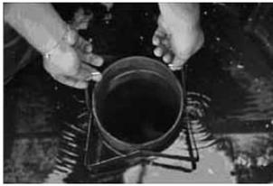
5. Aufstomsicherung nach oben wegziehen und aus dem Schacht heben
