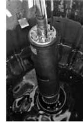
1. Schlammpumpe über das Absaugrohr in den Schacht herablassen
