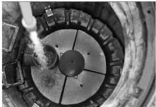
1. Wasser in den Ringraum zwischen Filtern und Schachtwand fließen lassen
