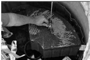
1. Seilzug in Filteröse einhaken und Filter ganz aus dem Schacht herausziehen
