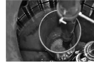
2. Wasser oberhalb der Filterelemente in das Wartungsrohr pumpen; wenn der Wasserspiegel zu stark absinkt mit Trinkwasser nachfüllen
