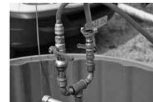
2. Kompressor und Frischwasseranschluss anbringen. Luft und Wasser in die Spüllanze einleiten.
