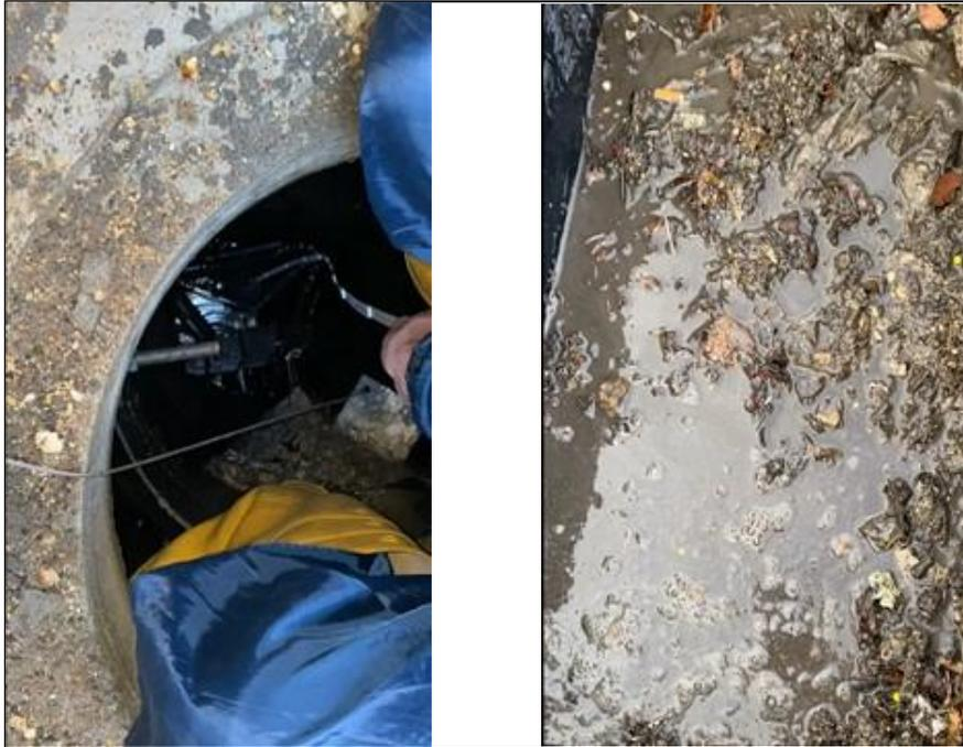
Bild 3-8: Messen des Schlammspiegels mit dem Zollstock (links); ausgepumptes Sediment (rechts)
