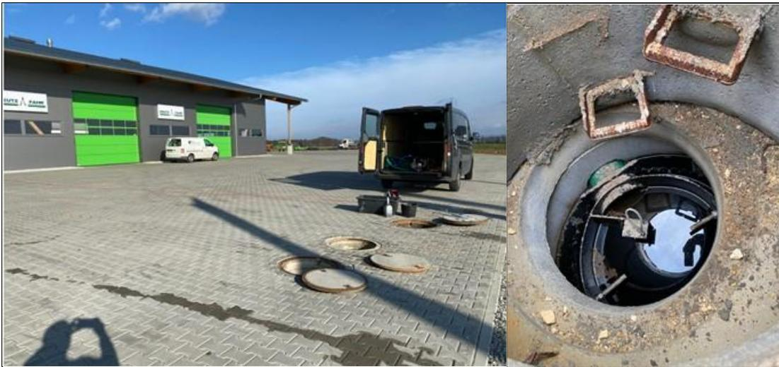
Bild 3-6: Schacht vor der Wartung (links); Blick in den Schacht mit eingebautem Hydroshark (rechts) (Beton- und Kiesreste vom Schachteinbau)
