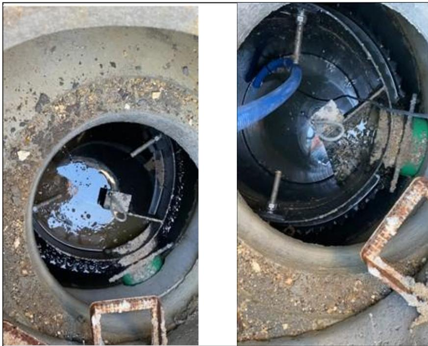
Bild 3-7: Hydraulische Prüfung (links); Absaugen des Schachtes (rechts)
