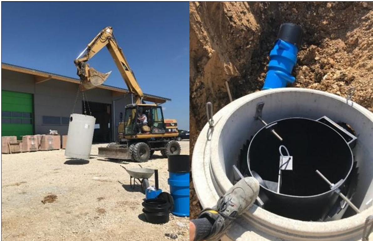
Bild 3-1: Einbau des Hydrosharks DN 1000
