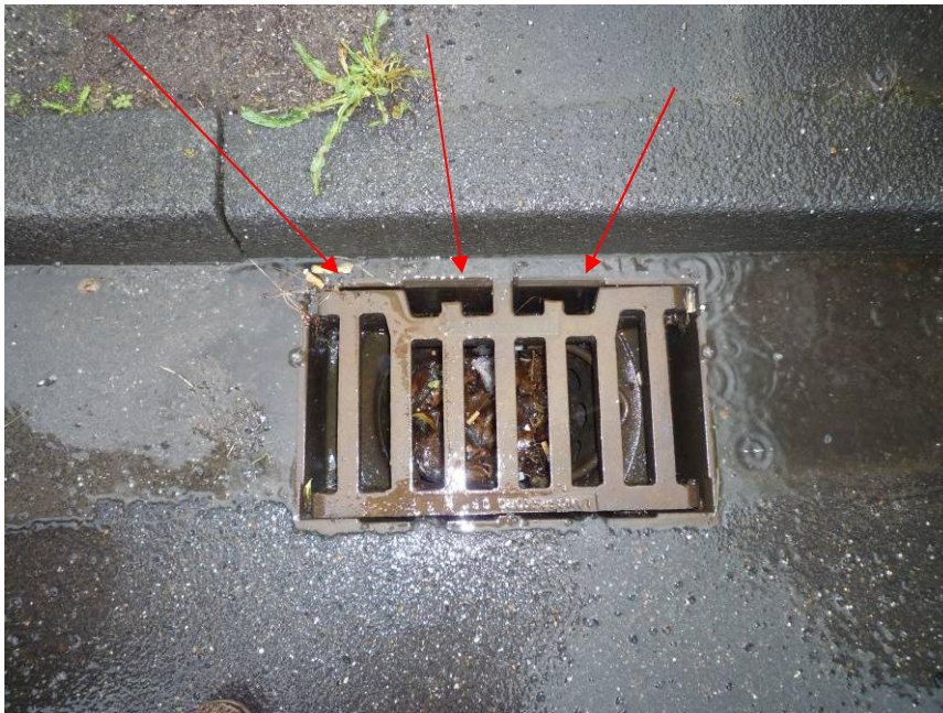
Abbildung 60: Zufuss zum Filtersack im Straßenablauf PL-07:
