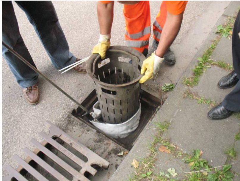
Abbildung 1: Einsatz des Geotextil-Filtersacks
