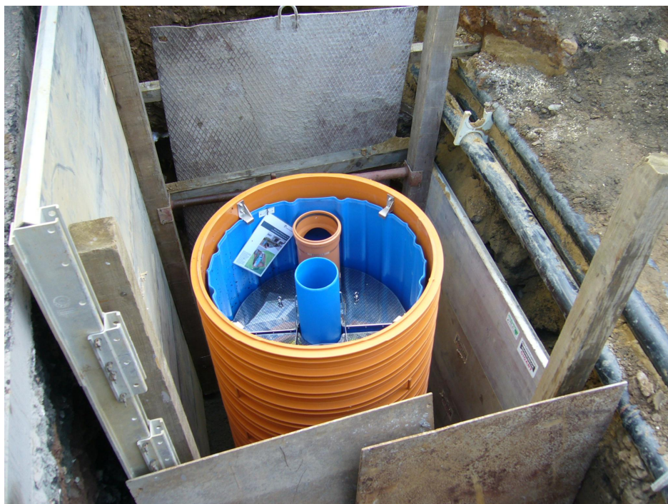
Abbildung 59: 3P ohne Schachtdeckel in der Baugrube
